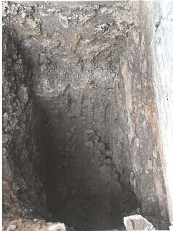
Zdjęcie 10,11,12. Widoki fragmentów ścian fundamentowych
