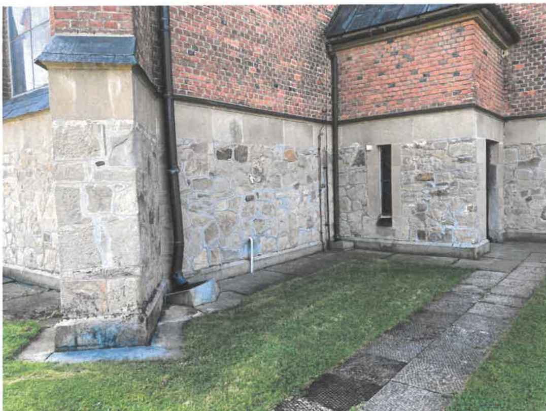
Zdjęcie 3. i 4. (od góry) Widok na elewację północną. Widok na fragment strefy cokołowej elewacji zachodniej.
