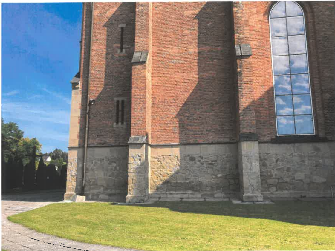
Zdjęcie 8. i 9. Widoki fragmentów elewacji zachodniej i południowej
