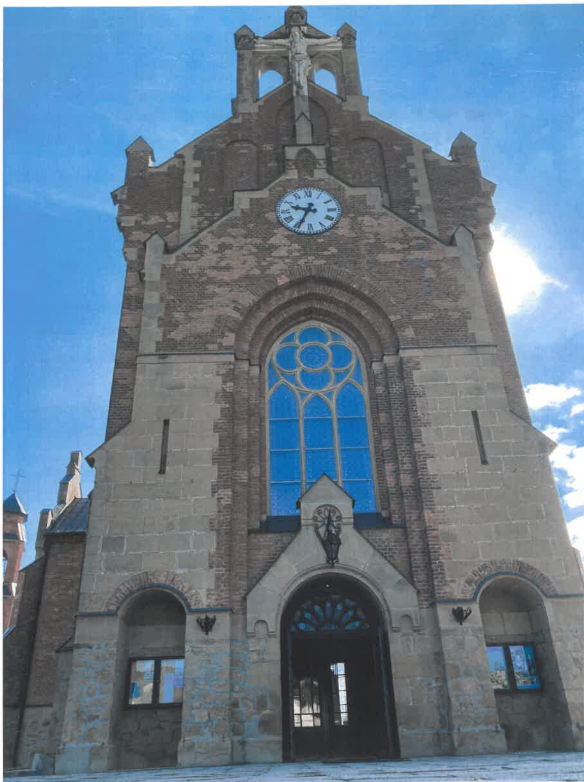
Zdjęcie 1. Widok na elewację frontową – zachodnią
