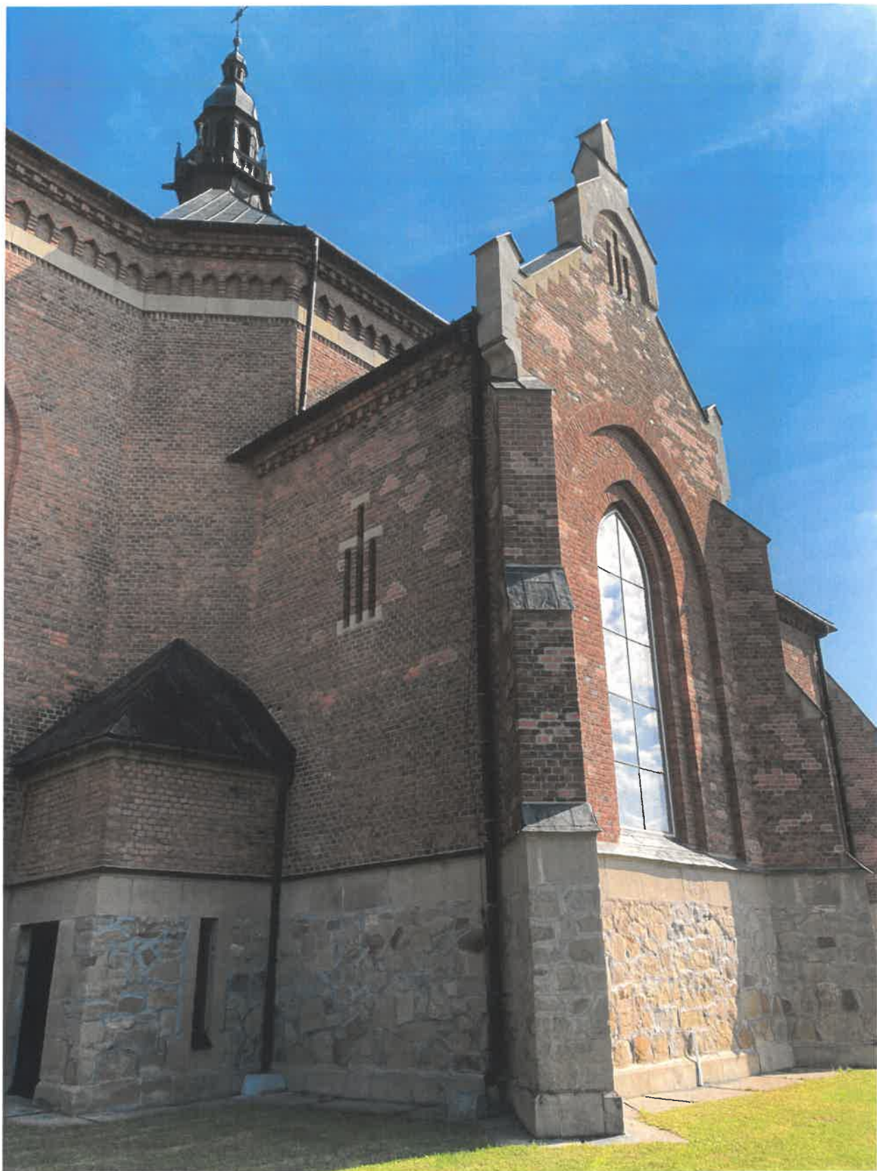
Zdjęcie 5. Widok na fragment elewacji południowej
